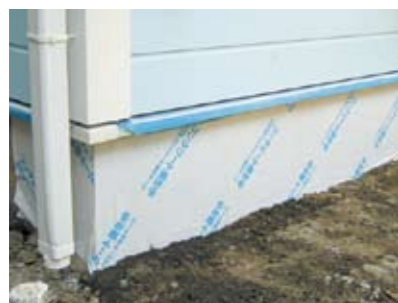
コンクリート保水テープ 2227HP 施工例
