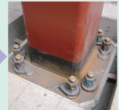
グラウト充填完了
