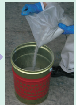
水とグラウトの混ぜ合わせ
