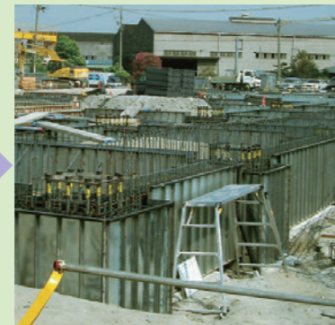
型枠・コンクリート打設
