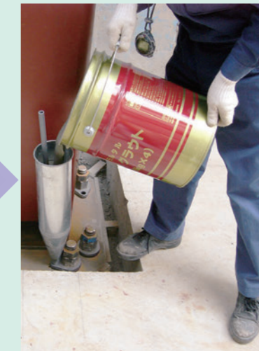
グラウトの注入
