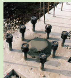
レベルモルタル
