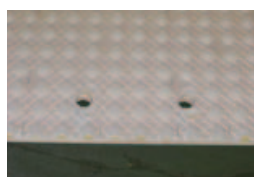
貫通孔の施工例
