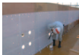
型枠への貼りつけ
