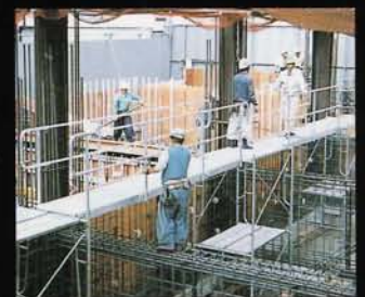
両サイドの桝組足場のパイプに ライトブリッジのフックを掛けて 安全通路が出来上がります。
