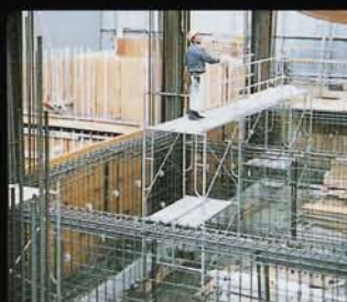
桝組足場で島を作る。
