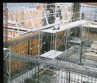
島と島の上にライトブリッジを レッカー (クレーン) で降ろす。
