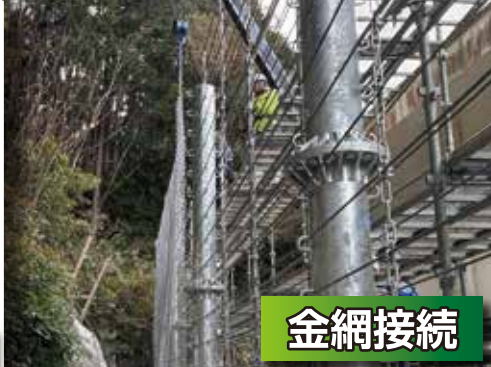
ターンバックル締付け
