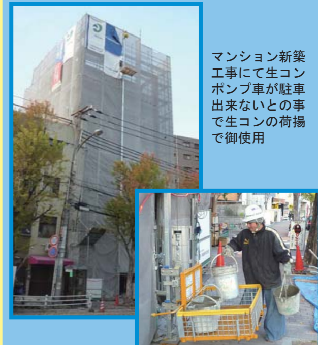
病院改修工事にて内装材の荷下ろしボード等の荷揚で御使用
