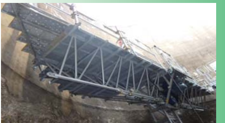
特に苦労したのは躯体形状が綺麗な円形で無かった為張り出し足場調整に時間を要しました
