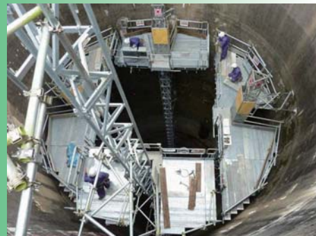
デッキ部分はクレーンが使用出来なかったため基本的に手組で連結しました
