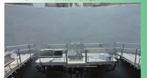
丁寧な仕上作業でこの躯体もよみがえりました
