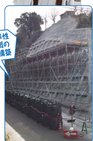
法面足場として
