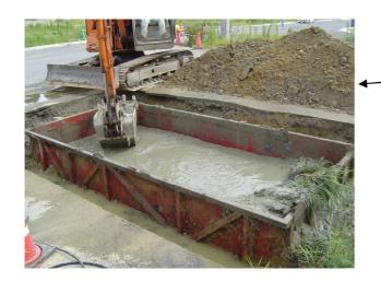
鋼製ピット内の水を水中ポンプにて排出し 内部の泥を取り除いてください。
