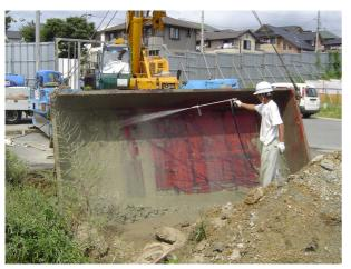
鋼製ピットを先にトラックに積み込み、ピット内に タイヤ洗浄機本体を入れて積み込みます。
