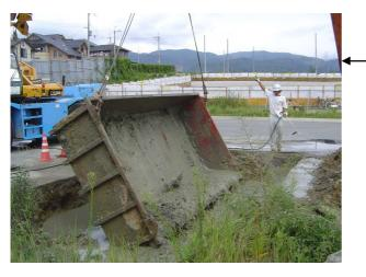
ピットを2点で吊上げ中の泥を取り除く。 (無理に吊上げるとじットが変形する恐れがあります) ピットを4点で吊上げ底部・外側の泥を洗浄する。
