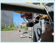
動かない場合はホイストの故障が考えられますのでお手数ですが取替お願い致します ワイヤー点検の要領で受金具をセットしてホイストワイヤーを切断しホイストを取替下さい
