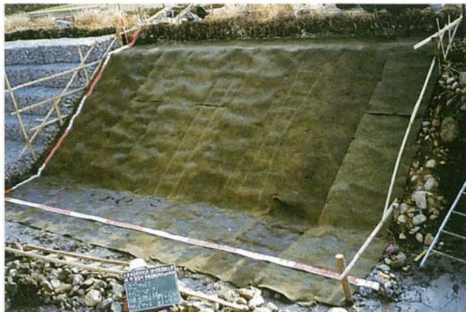
① 護岸工かごマット 吸出防止材
