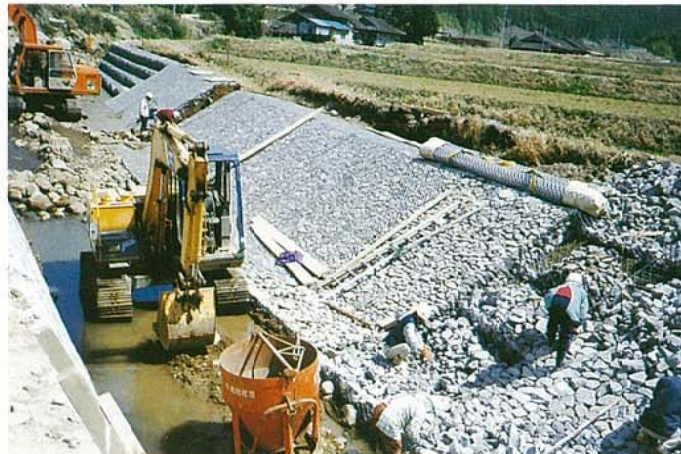
③ 護岸工かごマット 詰石状況
