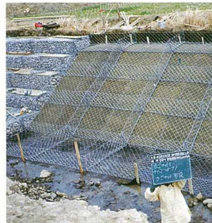
② 護岸工かごマット 布設
