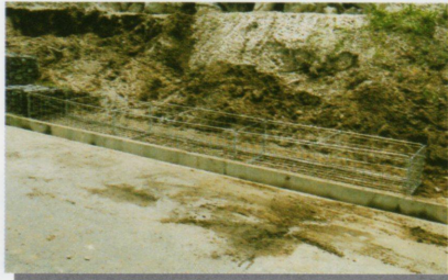
② かご枠設置
