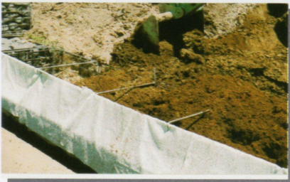
④ 土砂詰め(栗石詰め)
