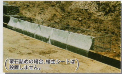
③ 植生シート設置
