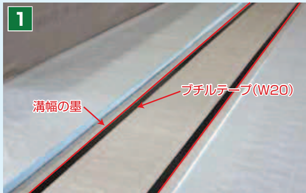
排水溝幅(W)の墨出し後、墨に合わせてプチルテープ(W20)を貼ります。
