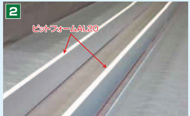
プチルテープの離型紙をはがし、ピットフォームAL20を圧着します。
