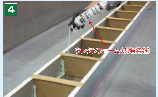
内側にウレタンフォーム(現場発泡)を吹付け、ピットフォームAL20とバリ材(幅止め材)を固定します。
