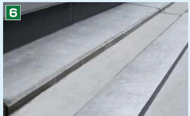
保護コンクリート打設後、ピットフォームを解体し、溝底の勾配をモルタルで仕上げて完了です。
