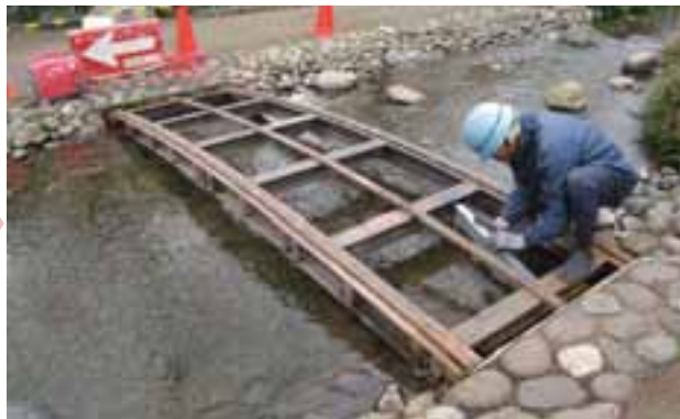
② 改修中 ※桁の鋼材を、そのまま有効利用 ※床材及び手すりを、プラ擬木に交換
