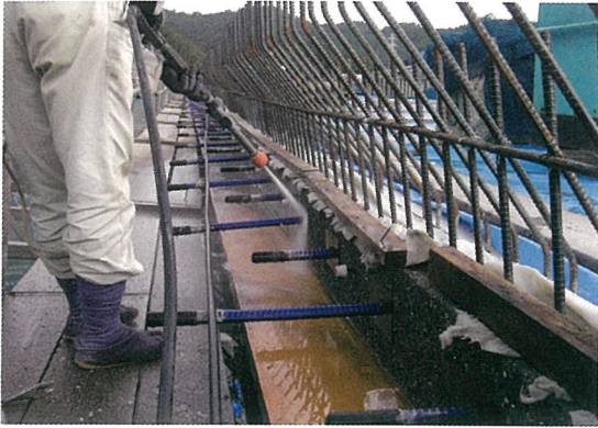
土木：橋梁での水洗出し作業中
