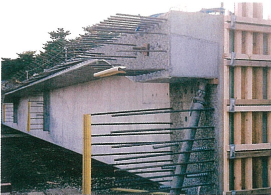
土木：橋梁での使用例
