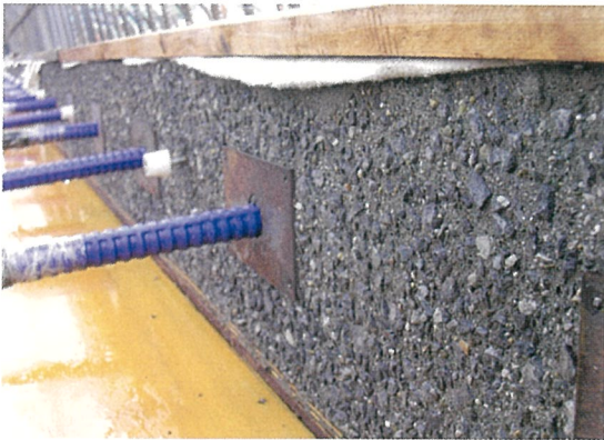
土木：洗出し後の打ち継ぎ面
