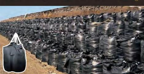
容量は 1 m<sup>3</sup>、中詰め最大重量は 20 kN
