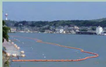
汚濁水の拡散を防止し、環境への影響を最小限に抑える汚濁水拡散防止フェンスです。
