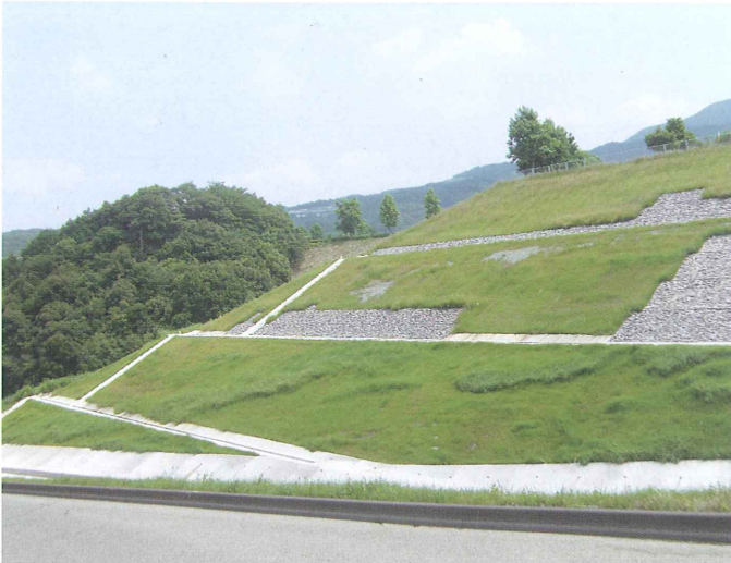
巖木地域開発道路整備事業市道岩の元線改良工事(その1)(佐賀県)
