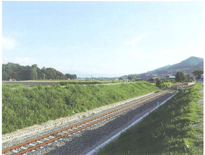
替佐・蓮間班尾橋りょう改築工事(長野県)
