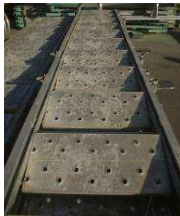
コンクリートケレン
