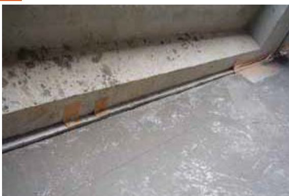
8 スラブコンクリート打設後
