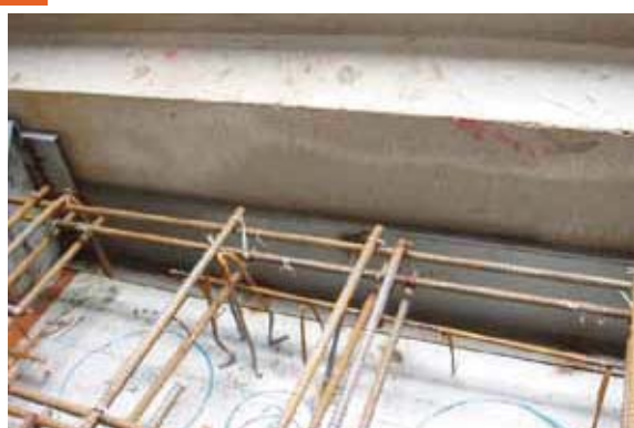
3 層間部分(Bタイプ取付前)
