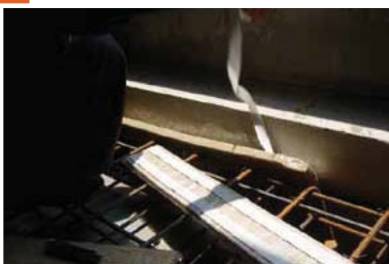
4 ソーカンパック(Bタイプ)取付後、りけい紙を剥がす
