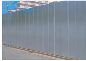
◎建設現場にて
