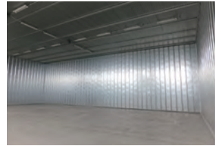
◎冷凍庫の内張りにも
